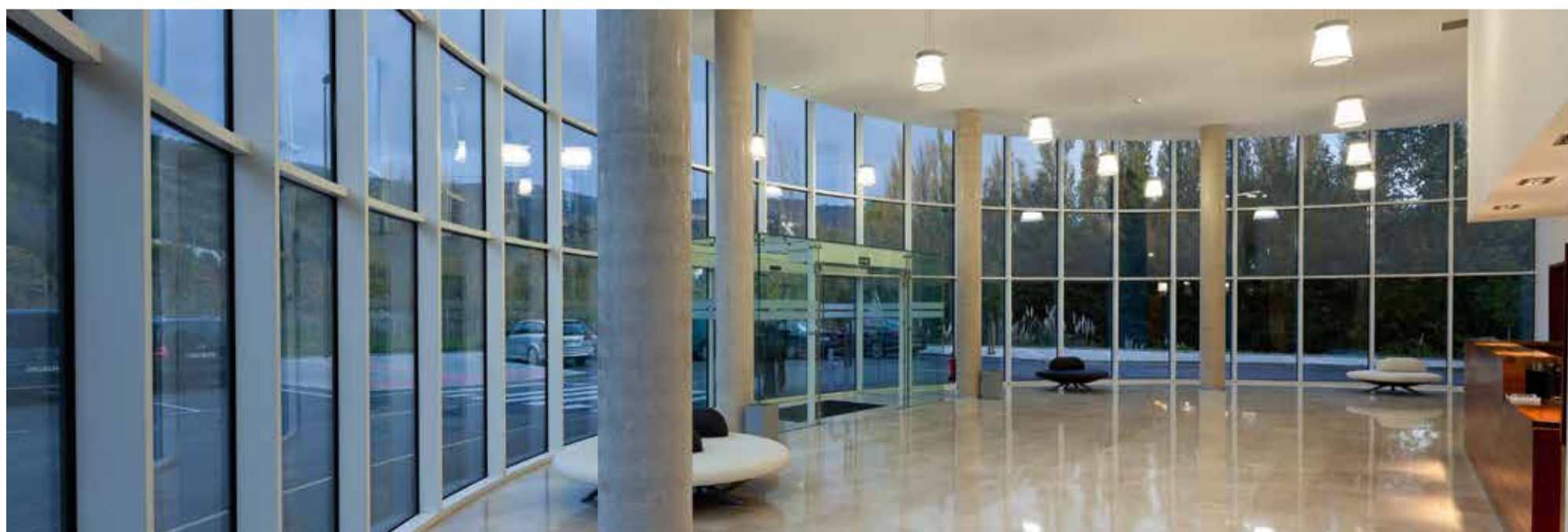
Detalle del hall de entrada donde destaca el muro cortina curvo realizado con el sistema GEODE SG
