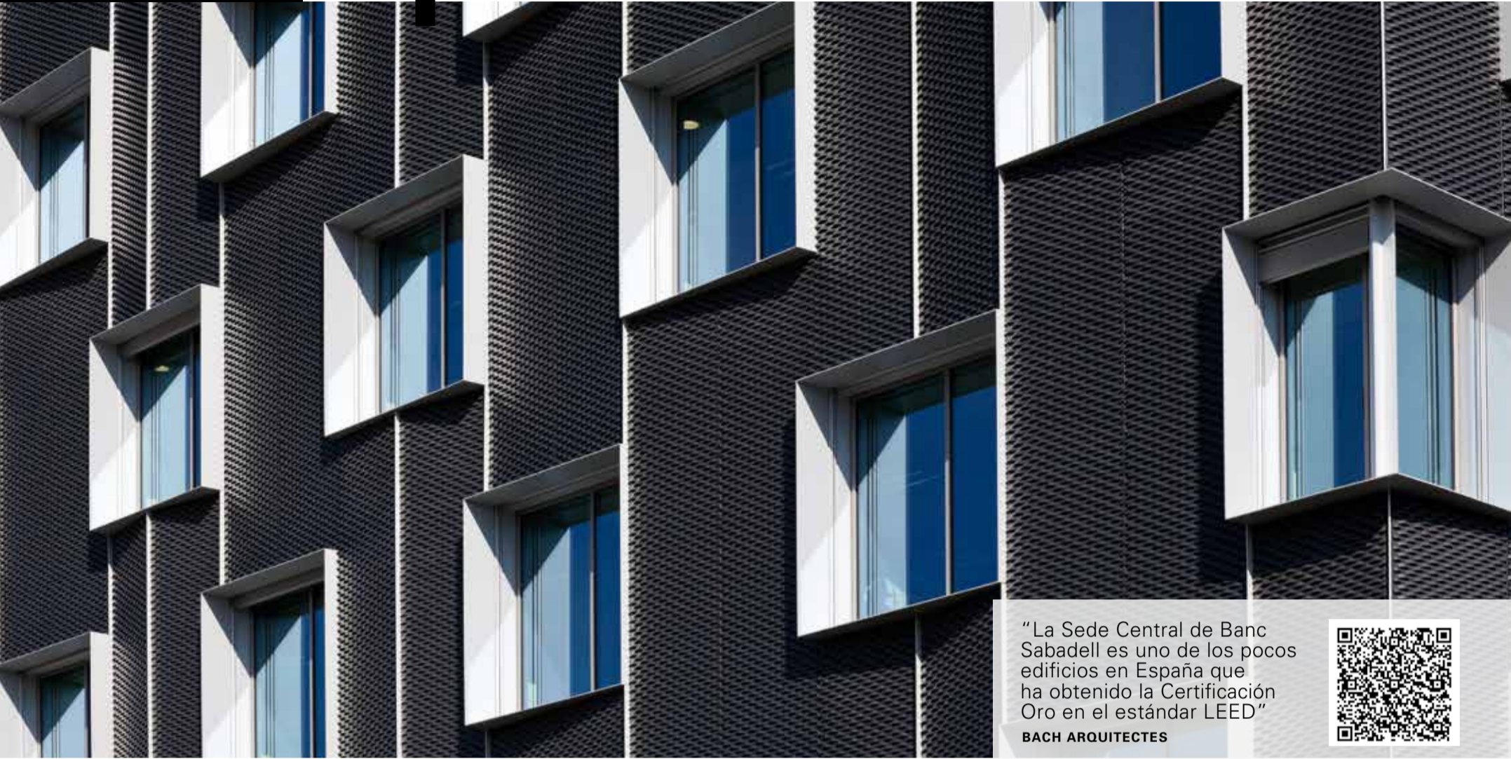
Detalle de las ventanas de hoja oculta Unicity instaladas en la fachada principal
