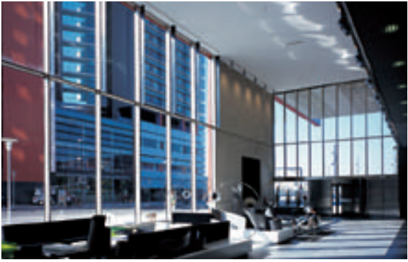
El hall se acristala mediante un muro cortina Mecano con parrilla tradicional
