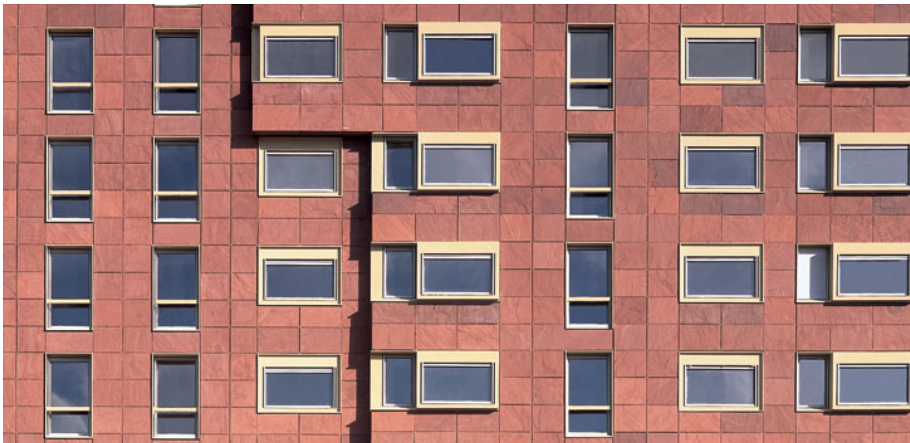
Fachada del Edificio Parque Doña Casilda en fase de ejecución de obra
