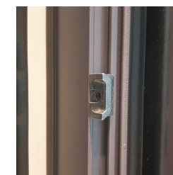
Ponto intermédio de fecho do lado do puxador e de articulação
