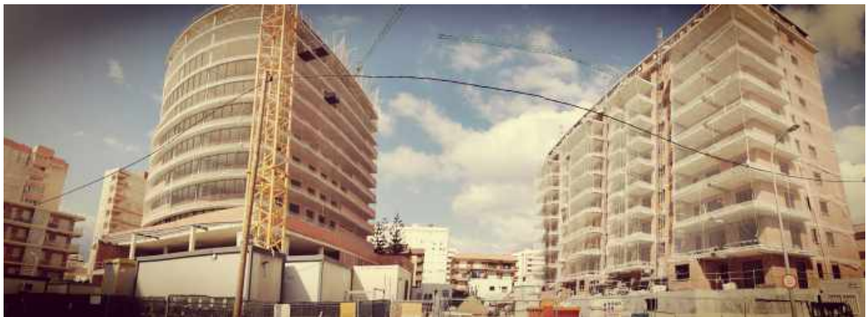
Hôtel en cours de construction Hôtel Caleia Gandia spa Espagne. Projet TECHNAL Architecte : Moratal Palomino. Fabricant installateur : entreprise ELS Poblets Crédit photo : Hydro
