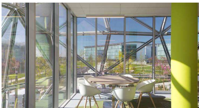
CRÉDIT PHOTO : TECHNAL - PHOTOGRAPHE P. LEDOARE ARCHITECTE : CALVO ET TRAN VAN ARCHITECTES
