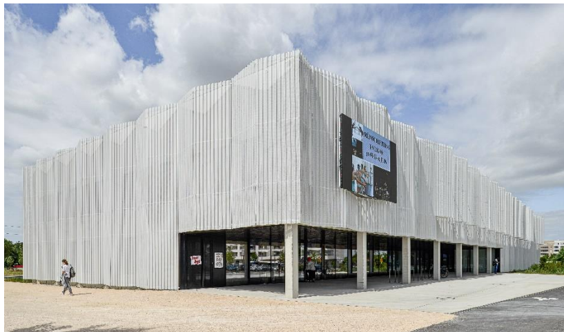
Crédit photo : TECHNAL - Photographe Sylvain Mille Agence PPA Architectures
