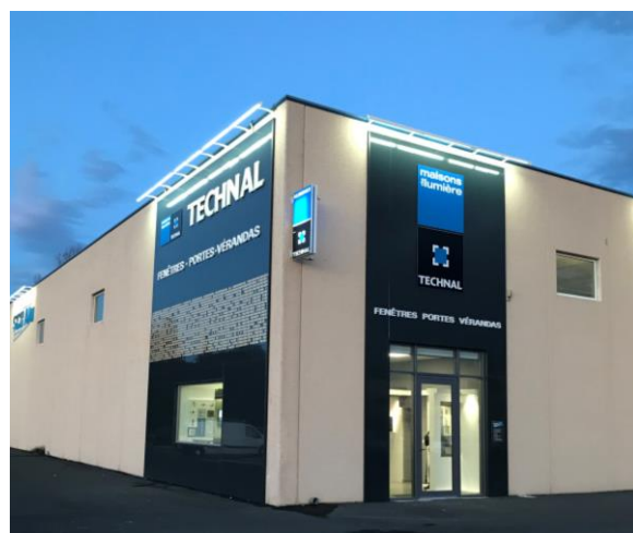
MAISONS DE LUMIÈRE BY TECHNAL - CANOHÈS (66) CRÉDIT PHOTOS TECHNAL
